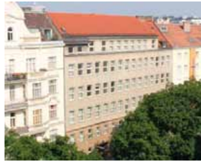
Kindergarten und Volksschule am Sebastianplatz
