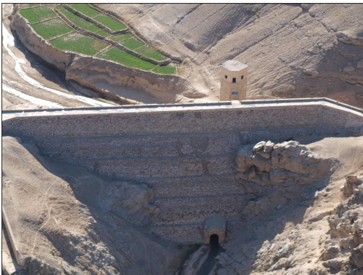
Obr.9 – Letecký snímek vzdušného líce hráze.
