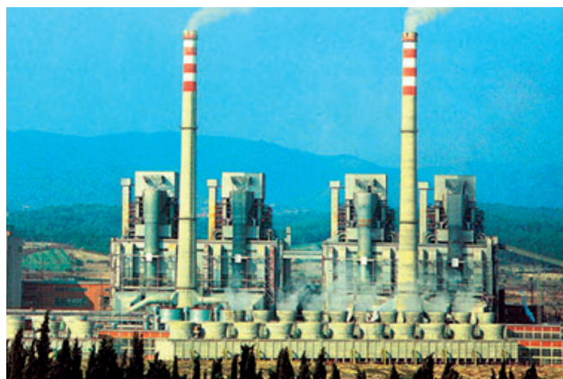
Elektrárna Soma (Zdroj: www.tasarimltd.com.tr )
