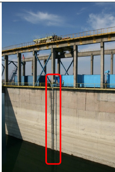
Měřící stanice na přehradě Cotesti
