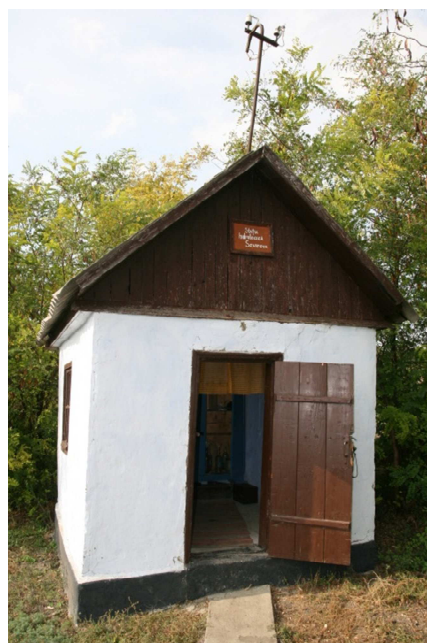
“Domek” ve kterém je umístěna řídící jednotka, Sevrova
