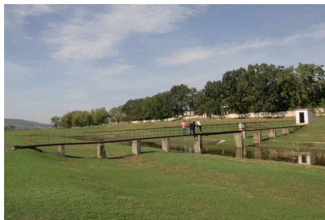
Pohled na celý měřicí profil Telenesti, mostek s radarovým snímačem a "domek" s řídicí jednotkou
