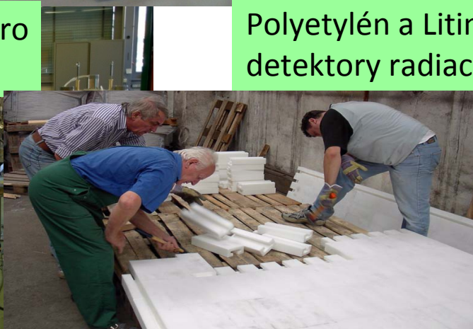
Stínění detektoru ATLAS:
