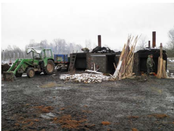
Obrázok 68: Pohľad na viacero paralelne fungujúcich kotlov na varenie vrbového prútia s pristaveným príviesom na dopravu materiálu.
