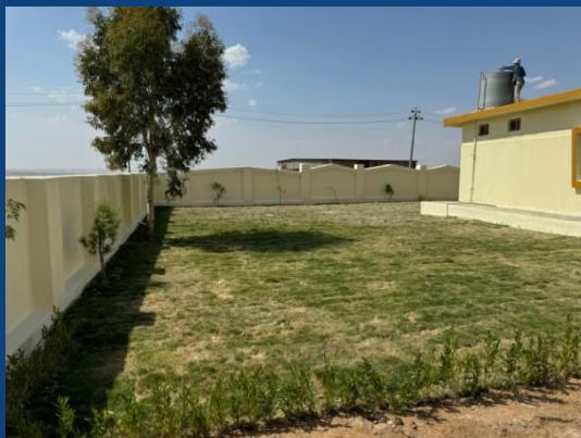
Irák - Renovace základní školy Qafar
