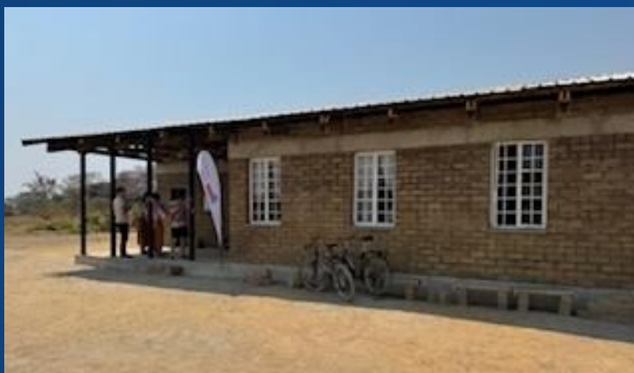
Zambie - Zahájení provozu nové dílny a výstavba multifunkční budovy pro střední školu v Kashitu
