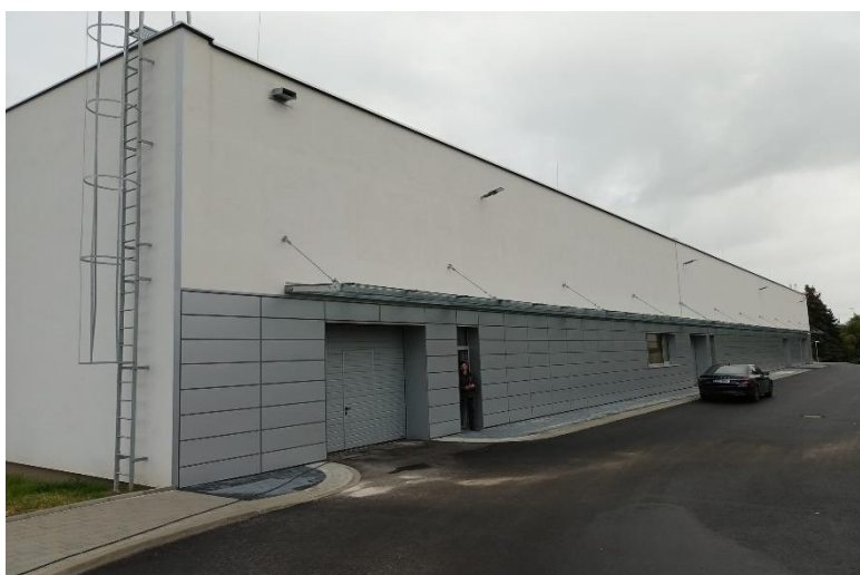
Dokončená rekonstrukce skladového areálu v Praze–Jivínách. MZV získalo moderní úložné prostory pro archiválii.
