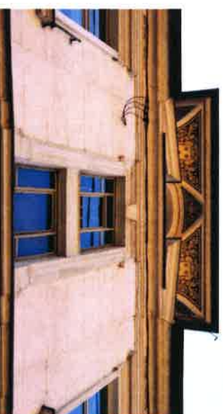
Vila Milada, družinska hiša Jana Dufféja, ki jo je zasnoval arhitekt sam, Karlovska cesta 20, Ljubljana – detajl pročelja Foto: Peter Mikševič
