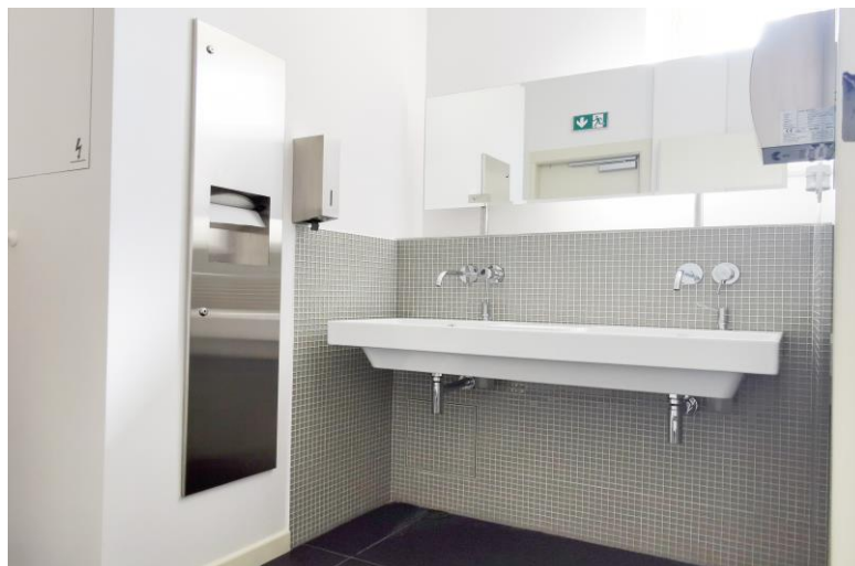
Rekonstrukce sociálních zařízení v sídle MZV v Janákově přístavbě Černínského paláce
