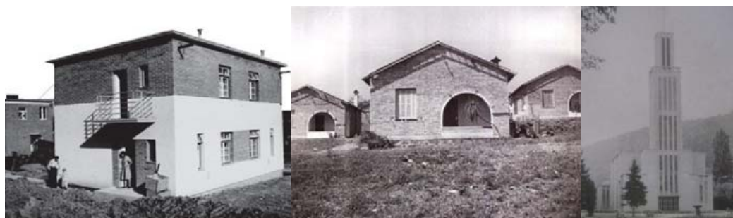
Figuras 190-192 Habitação multifamiliar em Zlín, 1939. Habitação unifamiliar Batatuba, 1940. Igreja católica em Zlín de Karfík, 1942.
