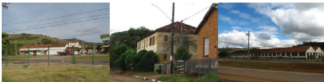
Figuras 123-125 Vistas de Batatuba, 2009-2010 – Antigos Restaurante, Edifício habitacional para solteiros/ hotel, Galpões fabris. Geórgia C. Capistrano da Costa.
