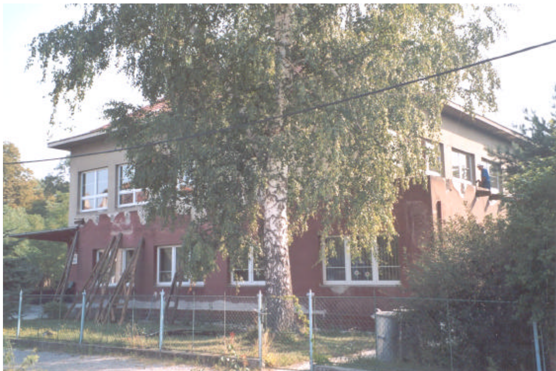
Základní škola v Horíně rok po povodni, dne 24. července 2003
