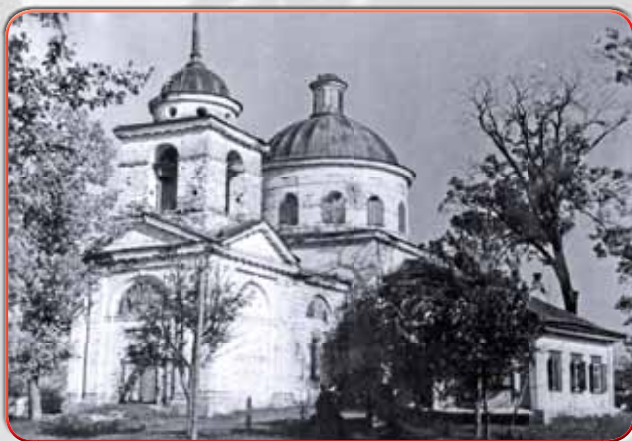
Kostel Zesnutí přesvaté bohorodičky v Sokolovu, velitelské stanoviště a místo smrti poručíka Otakara Jaroše. Kostel byl stržen na přelomu padesátých a šedesátých let.
